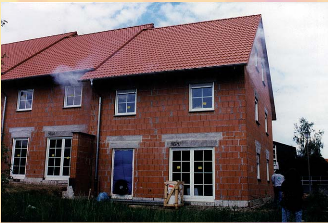
Abb. 5 Blower-Door und Nebelmaschine bei der Überdruckmessung.
